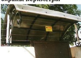
Електрошокова система охорони периметра представляє собою активну систему захисту від вторгнення, яка реагує на спробу вторгнення, відсилає сигнал на сервер та виконує функції без участі людини.
